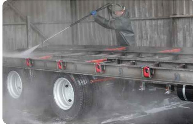
2. Vor der Lackierung wird das Fahrzeug von Schweißfetten gereinigt und mit Eisenphosphatierung vorbehandelt - unterstützt die Haftung von Lack und verhindert Korrosion
